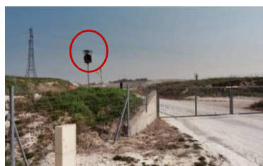
Site 7 : Carrière St Germain – Entrée
