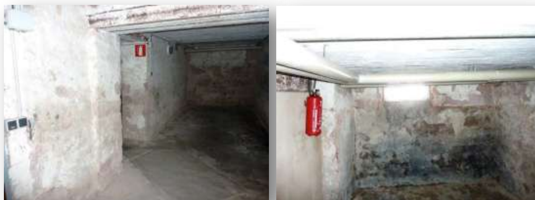
Photos 7 et 8 : sas d'accès à la cave et vasistas.
