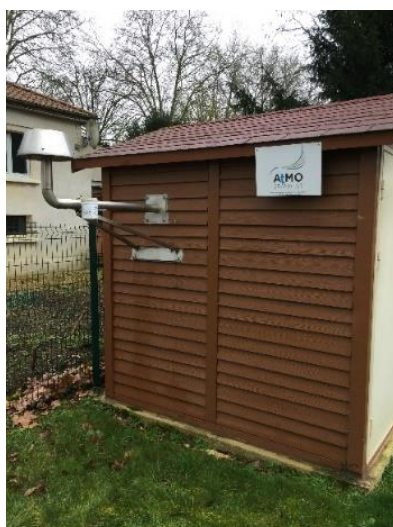
Tubes passifs installés à la station de Vitry-Le-François
