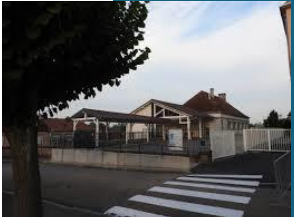
Ecole Julie-Victoire Daubié à Châtel-sur-Moselle (Source : Mairie de Châtel-sur-Moselle)
