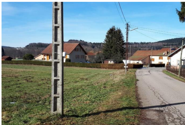
Tube passif sur poteau électrique à Fraize (Source : ATMO Grand Est)
