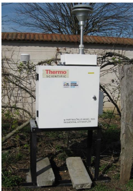
Appareil de mesure Partisol (Source : Air Lorraine)
