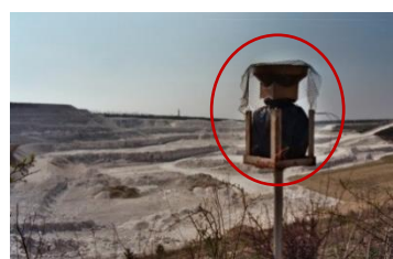
Site 11 : Carrière Coupéville - Talus
