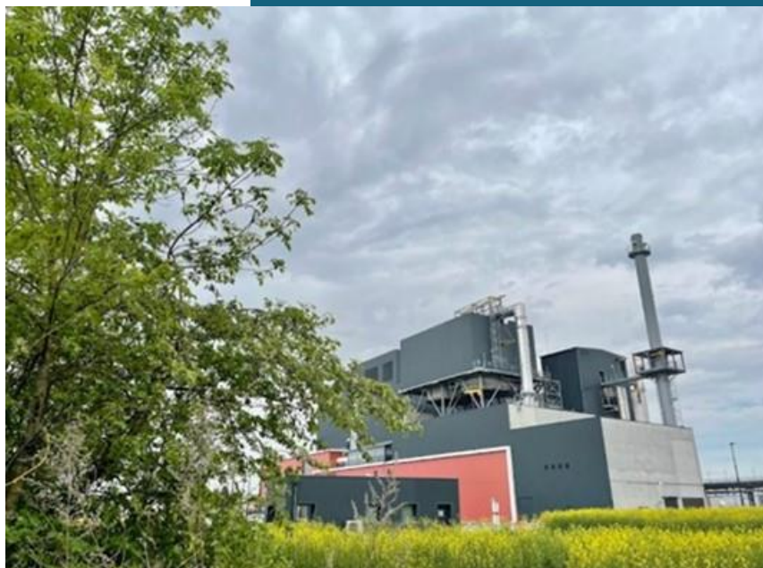
Usine Valaubia (Source : Veolia)
