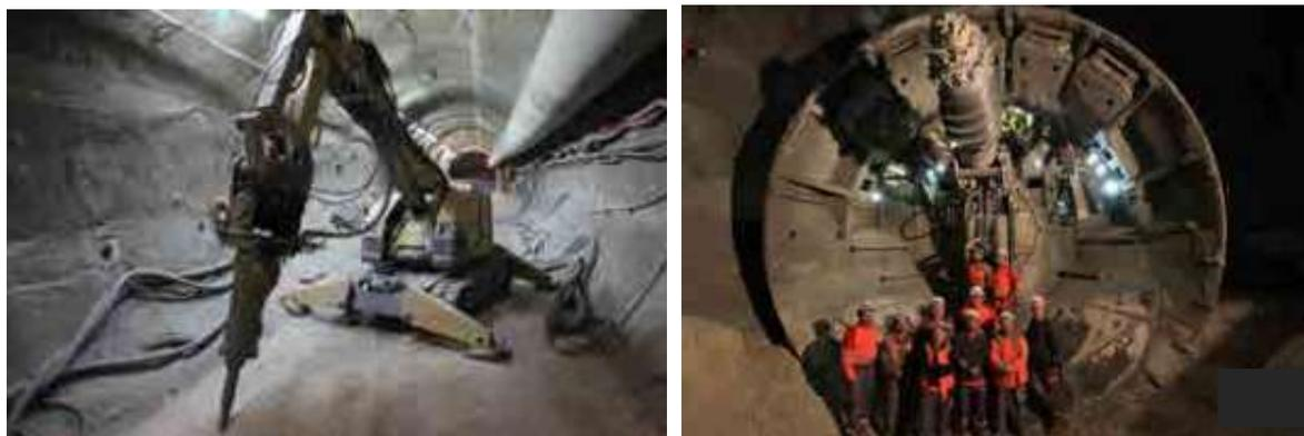
*Exemples de techniques de creusement des galeries : brise roche hydraulique (à gauche) et tunnelier à attaque ponctuelle (source ANDRA)*
