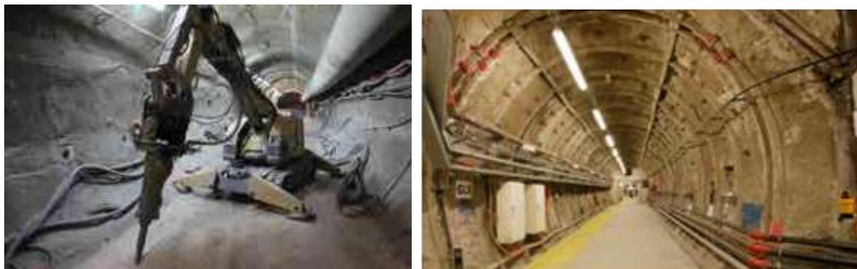
*Photographies présentant un exemple de technique de creusement de galeries (brise roche hydraulique, à gauche) et une galerie du laboratoire souterrain (source ANDRA)*
