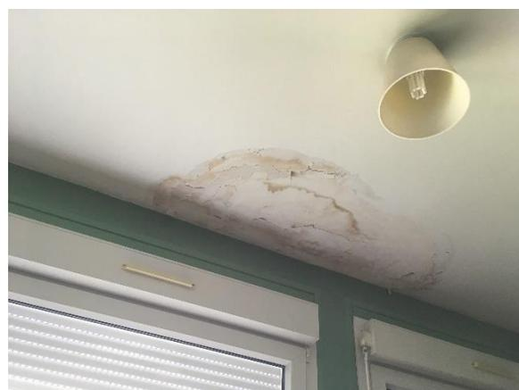
Figure 10 : Tache d'humidité observée dans une salle de classe du lycée D
