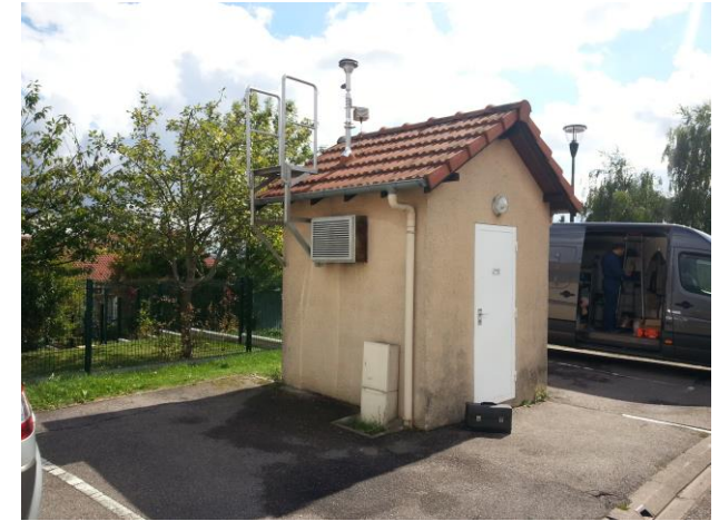
Station de mesures de Fléville
