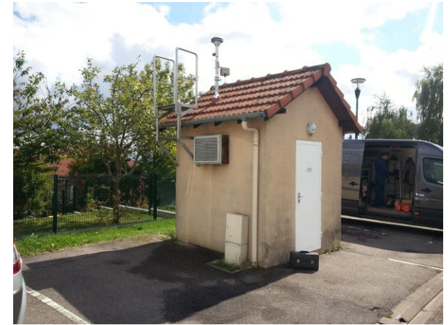
Station de mesures de Fléville
