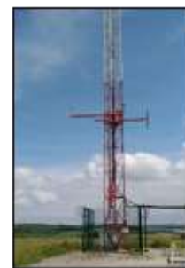
Figure 11 : station atmosphérique à Houdelaincourt (source : ANDRA)
