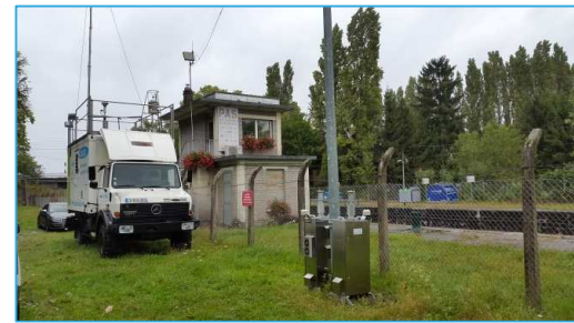
Site NE : rue du Rhin Napoléon, à côté du poste PAS donnant accès au bassin René Graff.
