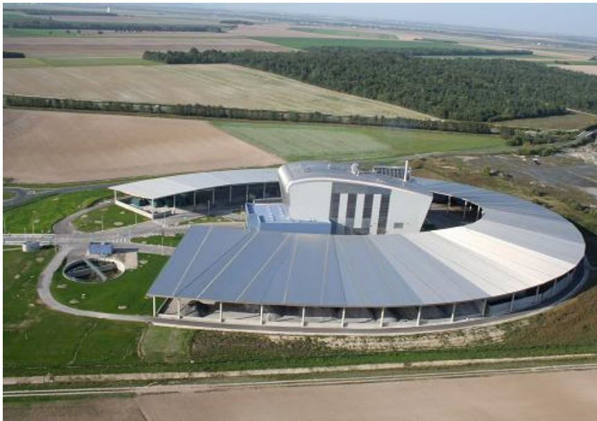
Figure 1 : L'Unité de Valorisation Energétique et Agronomique
