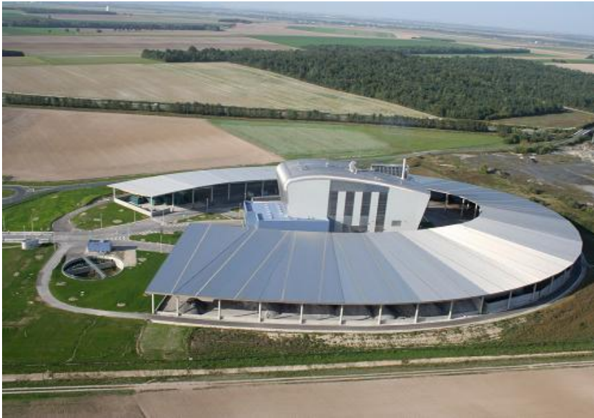
Figure 1 : L'Unité de Valorisation Energétique et Agronomique
