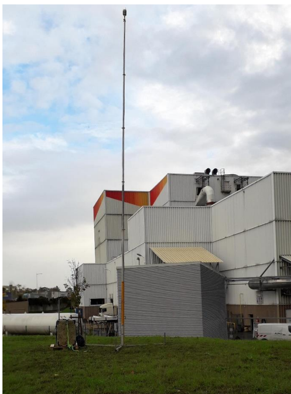
Figure 6 : Mât équipé d'une station météorologique installé sur le site de REMIVAL
