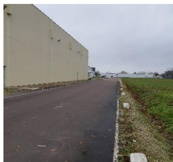
Figure 5 : Photographie du site B
