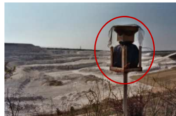
Site 11 : Carrière Coupéville - Talus
