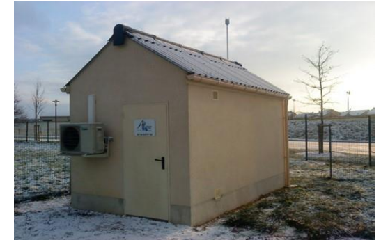
Station de mesure
