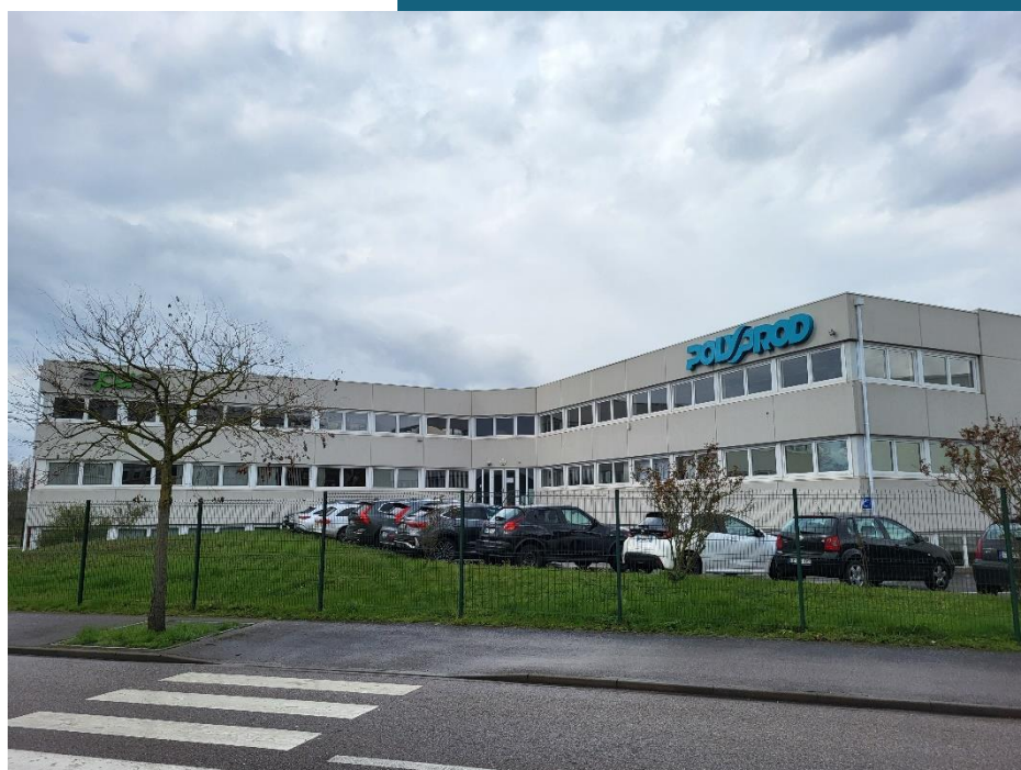
Figure 1 : Société Polyprod à Dombasle-sur-Meurthe (Source : ATMO Grand Est)
