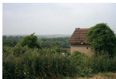
Site 4 : Lieudit Bayarne
