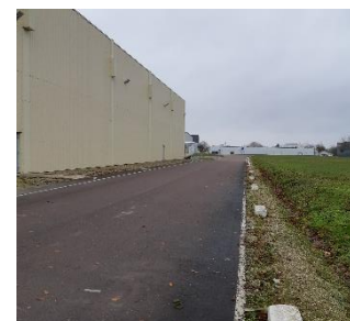
Figure 12 : Photographie du site B
