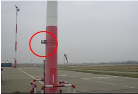
Site n°a2 : Entzheim, pylône à proximité des cuves de kérosène Plateforme aéroport
