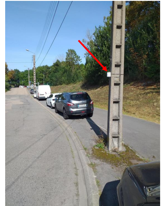
Photo site n°9 : rue du Couronné, dans le virage
