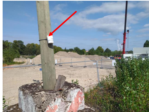
Photo site n°8 : rue des abattoirs, au niveau de l'emplacement du nouveau pont pour le BHNS
