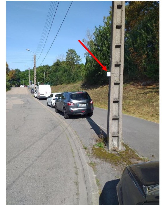
Photo site n°9 : rue du Couronné, dans le virage
