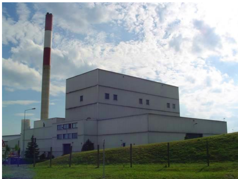
Figure 1 : Photographie de l'incinérateur
