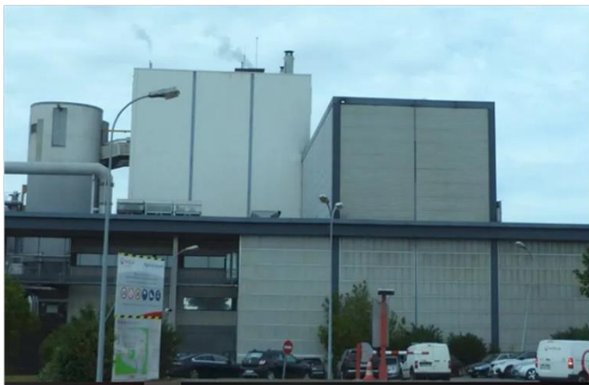
Figure 1 : L'Unité de Valorisation Energétique de SHMVD
