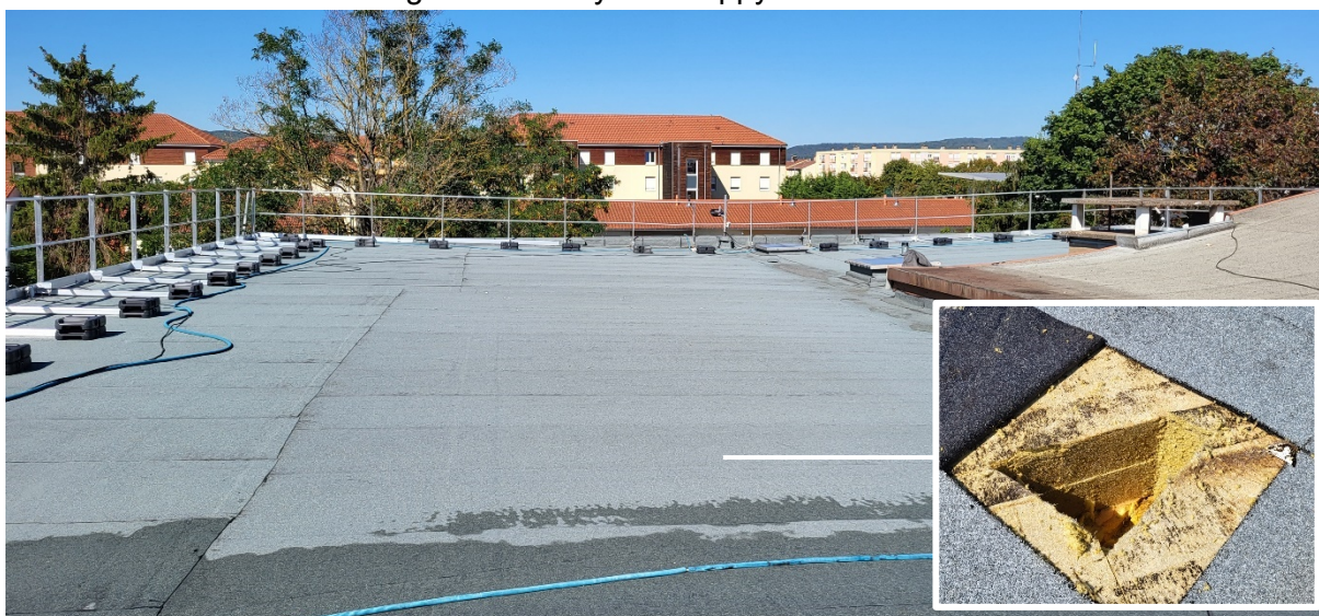
Figure 1 : Isolation du toit au-dessus de la salle Pelot
