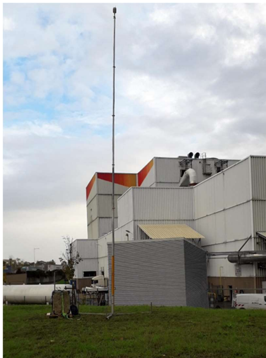
Figure 3 : Mât équipé d'une station météorologique installé sur le site de REMIVAL
