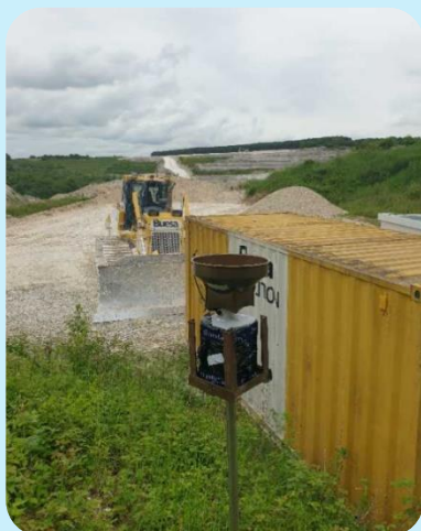
Carrière Coupéville entrée
