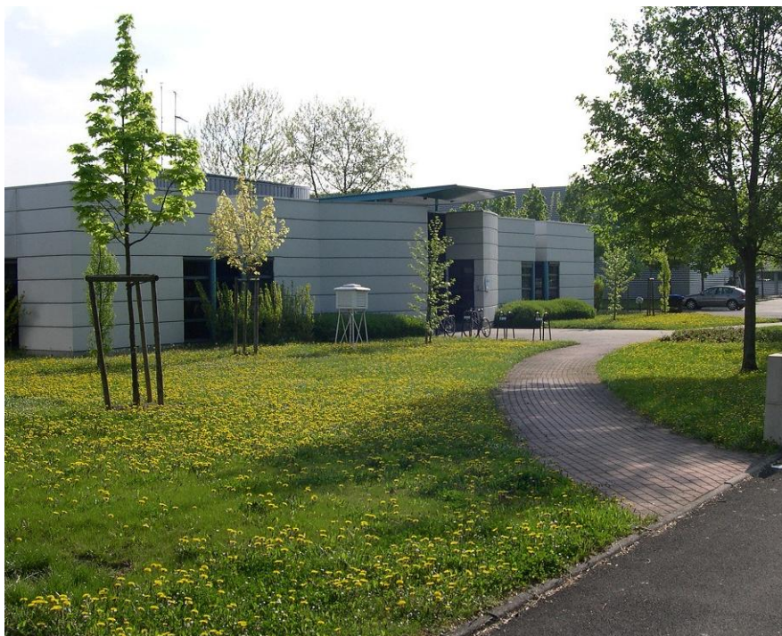
Site n°2 : Schiltigheim, 5 rue de Marid ( station fixe )
