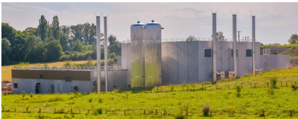
Photographie 2 : Nouvelle chaufferie biomasse de Toul (source : Toul énergie)
